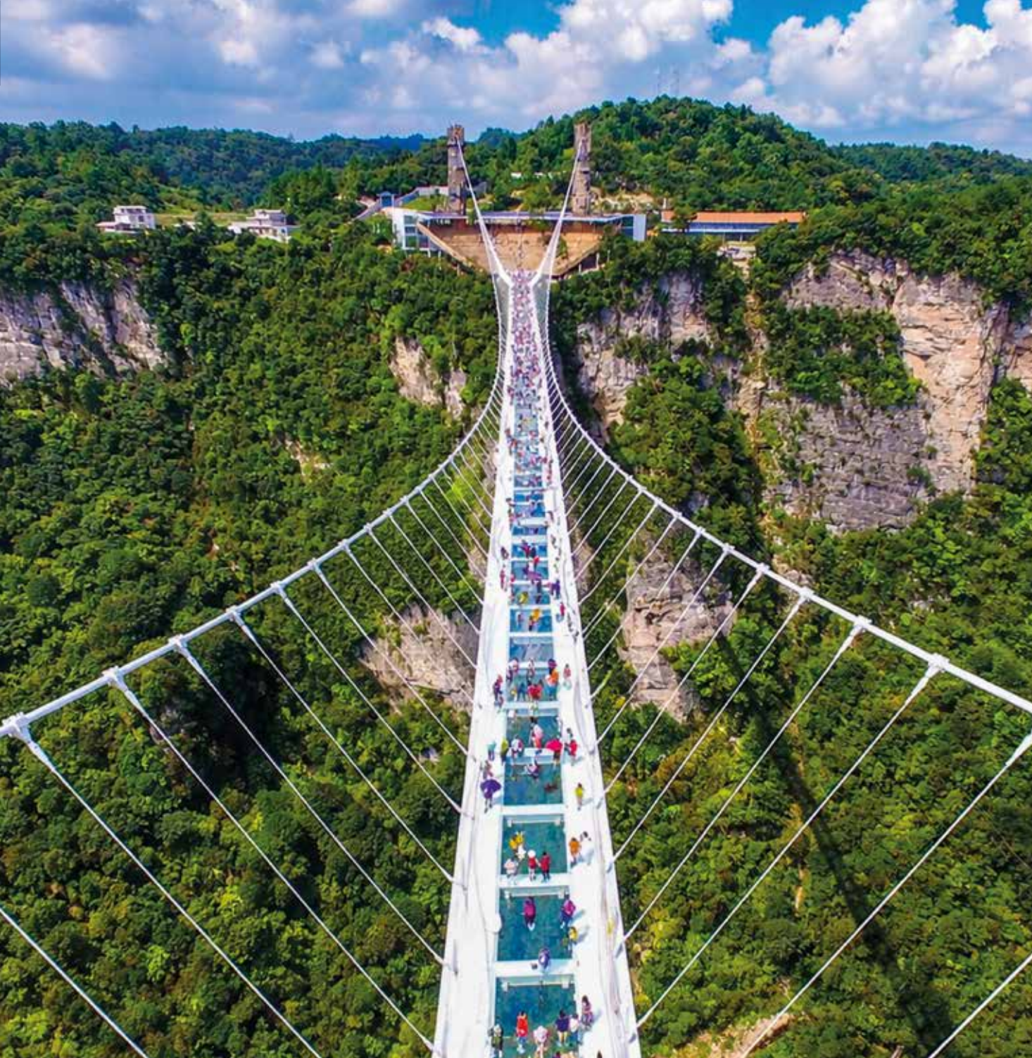
Die beeindruckende Glasbrücke Zhangjiajie hat eine Länge von 430 Metern
